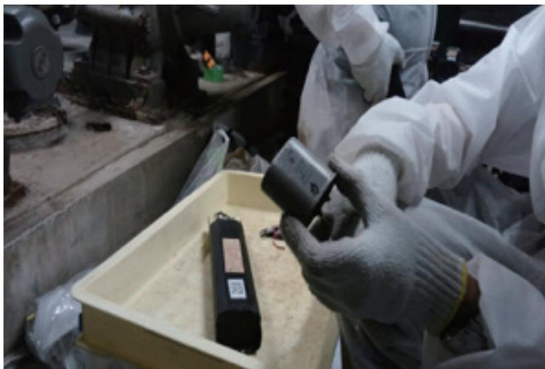
※目視により、安定器に膨張、腐食、油の漏洩等、PCB入りコンデンサの形状等に変化が生じていない場合、安全対策を行い取り外しを行います。
